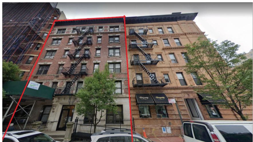
뉴욕 리디머 장로교회가 최근 매입한 맨해튼 어퍼 이스트사이드 지역 건물. ©구글
