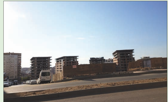
터키 남부 바트만 도시 난민 아파트 건설 현장
